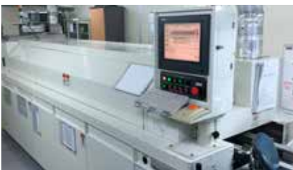
工場内表面実装設備
